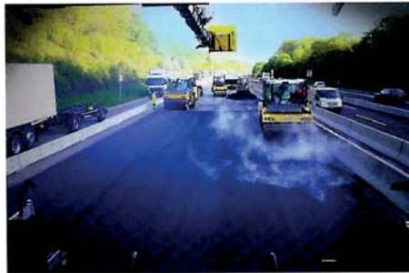
Der **Thermalprofilsensor des Pave-IR** erfasst mit Infrarot-Technologie präzise die Temperatur über eine Breite von bis zu 13 m.
