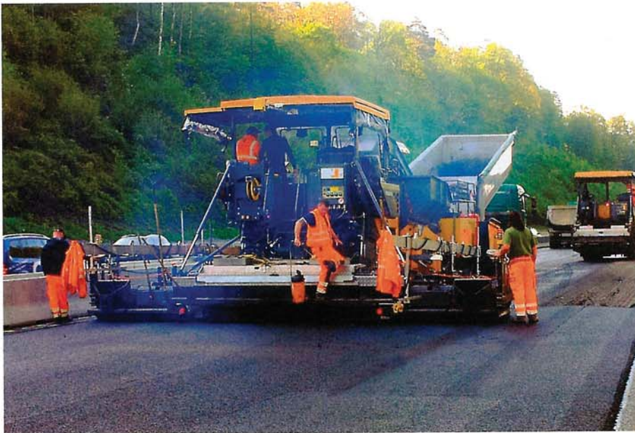
Prozessoptimierung, Temperaturerfassung und Dokumentation spielen beim Asphalt einbau eine immer wichtigere Rolle. | Fotos: Moba
