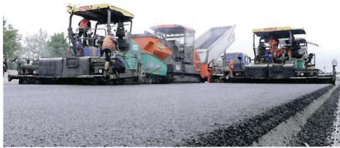
Bild 1: Baustelle A 7, hier wurde im Rahmen von QUATTRO BPO Asphalt erstmals mit MOBA Sensortechnik verknüpft
